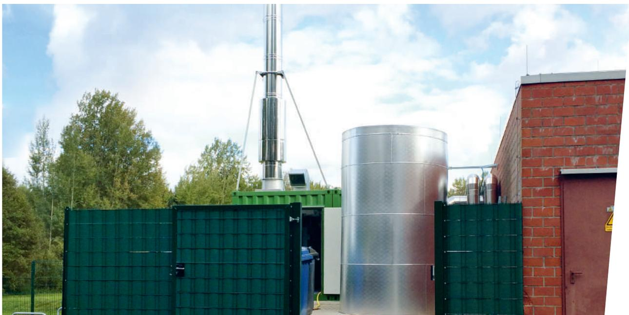
Das BHKW dient der Abdeckung der Wärmegrundlast der Wärmeabnehmer und wird mit Erdgas betrieben. Es läuft streng wärmegeführt und hat eine elektrische Leistung von etwa 50 Kilowatt sowie eine thermische Leistung von etwa 100 Kilowatt. Über einen DSL-Anschluss kann es aus der Ferne gesteuert werden.
