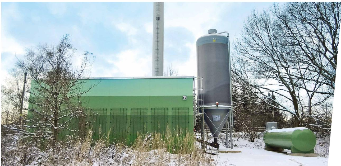
Das Heizhaus mit Holzpellet-Silo zur Lagerung des Brennstoffs wurde etwas außerhalb des Wohngebiets errichtet – so können die Pellets für die Bewohner des Quartiers fast unbemerkt in den üblichen Geschäftszeiten angeliefert werden. Die Wärmeverteilung erfolgt über ein Nahwärmenetz mit einer Trassenlänge von etwa 3.500 Metern. Rohrleitungen der höchsten Dämmklasse reduzieren die Wärmeverluste beim Transport vom Heizhaus zu den versorgten Gebäuden auf ein absolutes Minimum.
